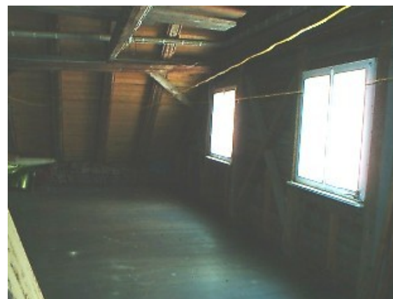
sehr großer Dachboden
