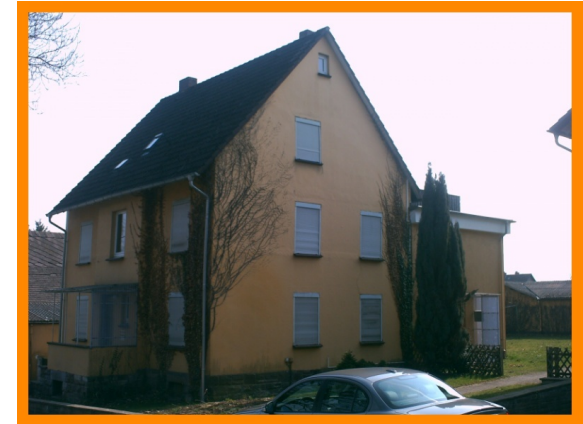
Haus 1 mit seitlichem Anbau
